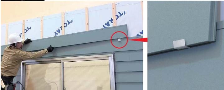
**Step ③** 治具と反対側のサイディング板の端を釘で留める
