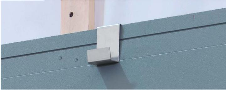
**Step ②** 治具のフックに施工するサイディング板の端を乗せる
