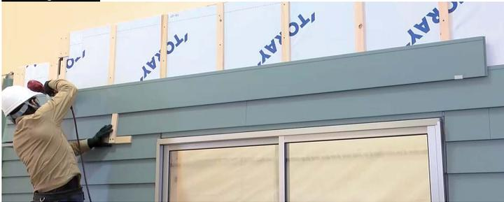
**Step ④** 治具を外し、板がずれないように手で支えながら釘で留める
