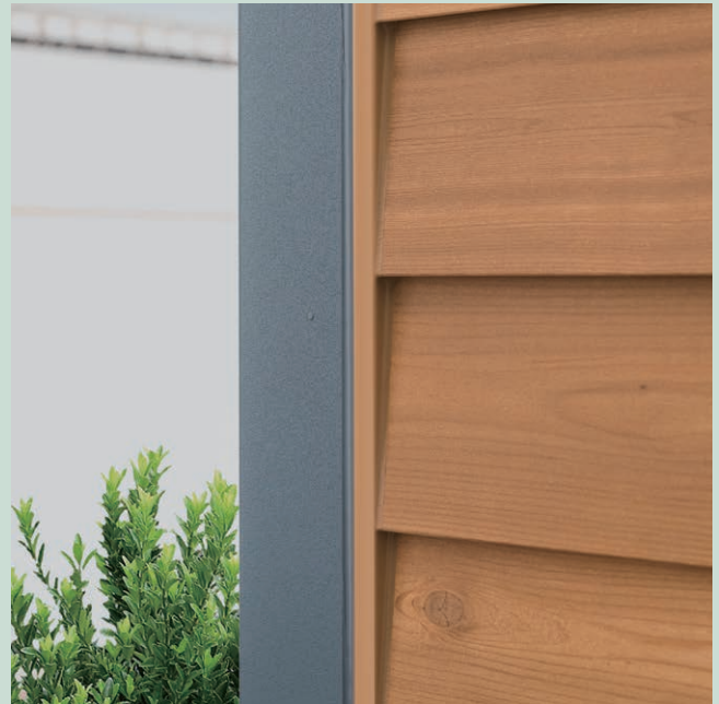
コーナー部「ラップサイディング+窯業系サイディング」納まり例
