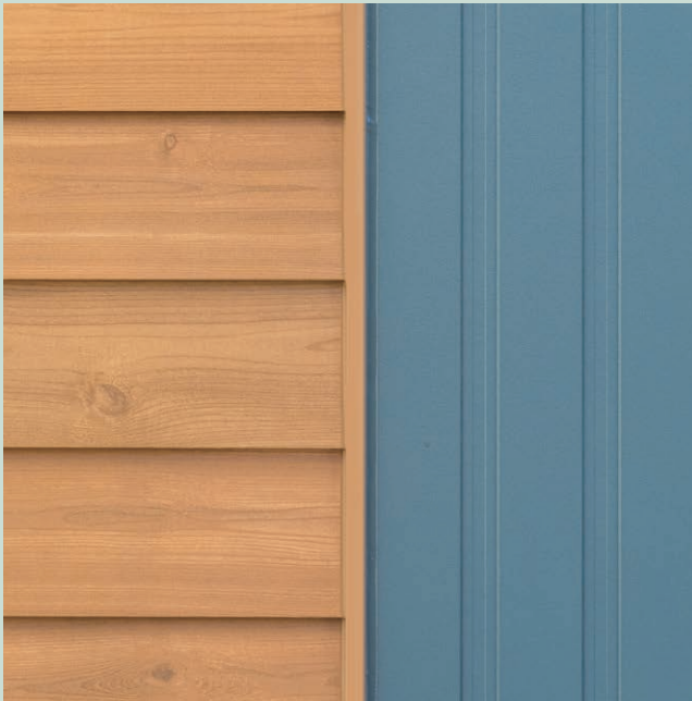
同面部「ラップサイディング+窯業系サイディング」納まり例
