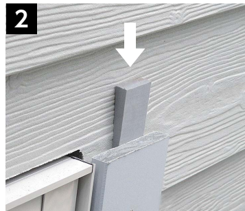
化粧モール上部より「角度調整材」を 挿入・貼付
