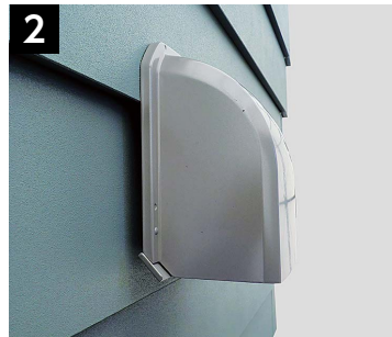
換気フードを取付
