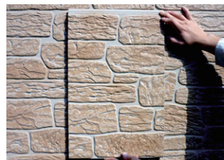
●施工後約11年の物件例
