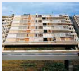
屋外実暴露試験
